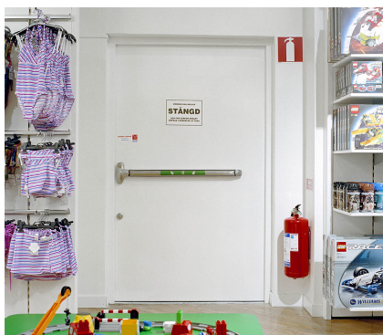
Sikkerhetsdør med panikskåte, magnetkontakt og mikrobryter i lås er et vanlig syn i butikker.
