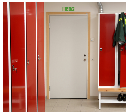
Massivdør med laminatoverflate og plastkantlist i omkleddingsrom
