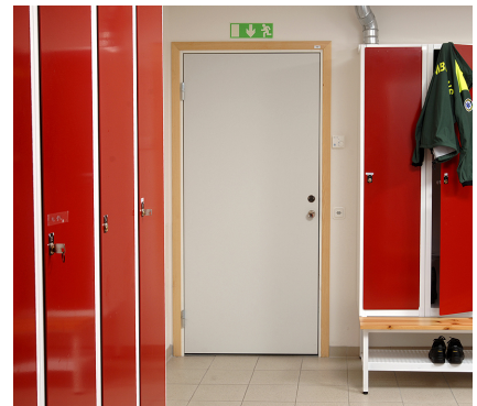
Massivdør med laminatoverflate og plastkantlist i omkleddingsrom
