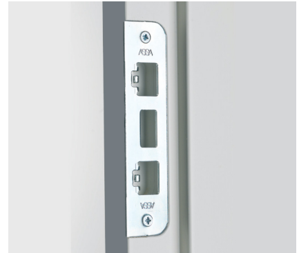
Sluttstykke for låskassen Assa 310.
