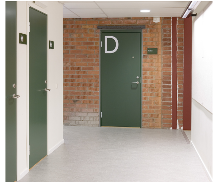
Massivdører i 28 dB til toaletter, og Daloc-dør med lydklasse 43 dB til danseundervisningsrom
