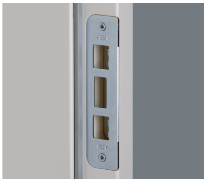
Sluttstykke for låskassen
